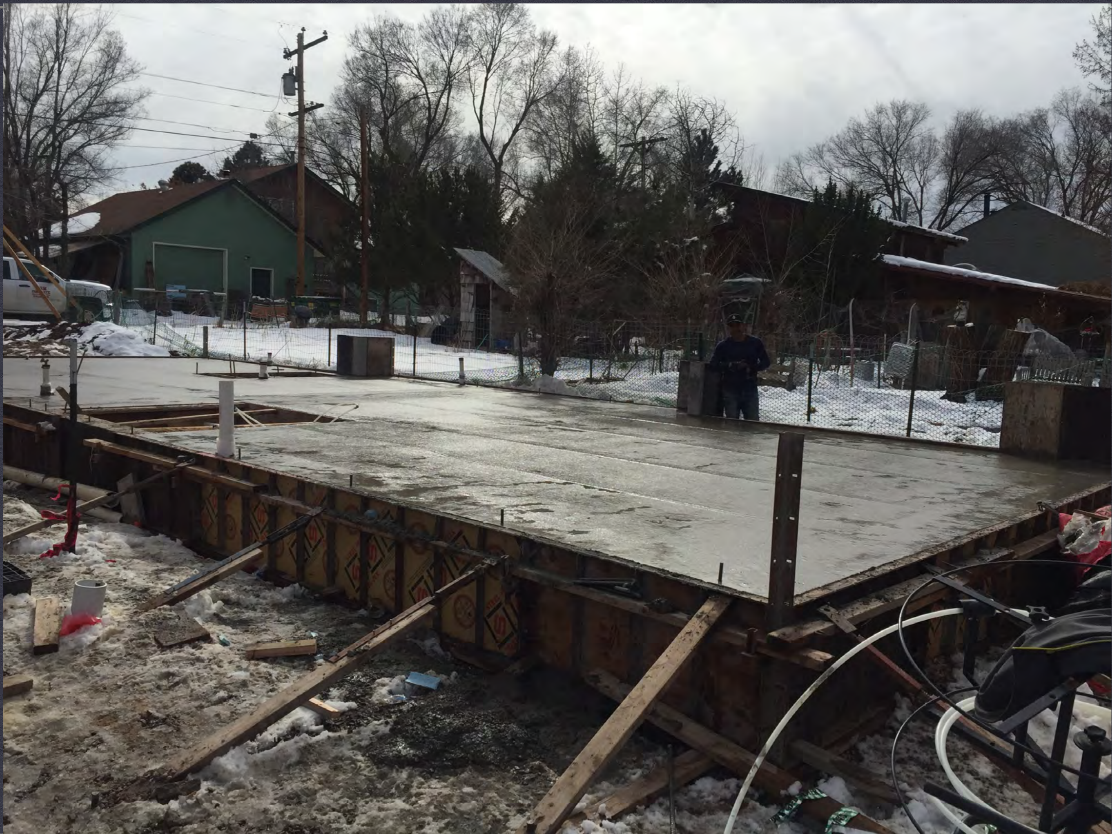
MARCH 5 - SLAB POUR
